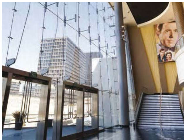
FACHADA TEATRO AMC, CALIFORNIA
